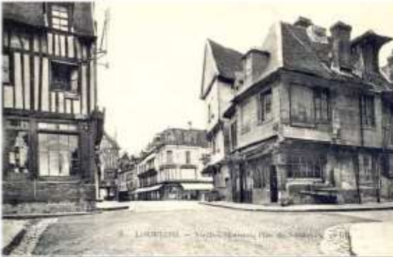
L'îlot non reconstruit vu de la rue de la Laiterie
