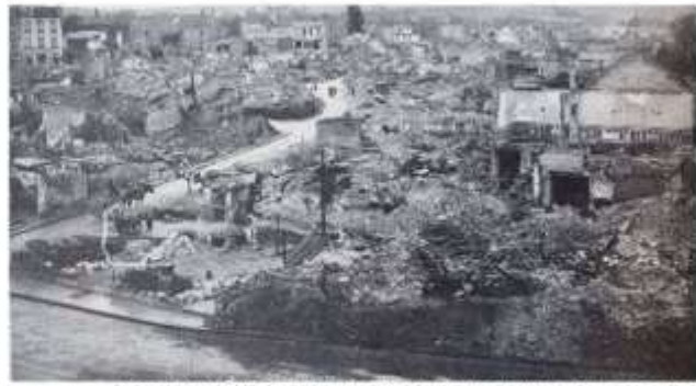
Les deux côtés de la rue du Matrey sont totalement ruinés.
