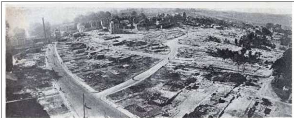
Après déblaiement et arasement le centre ville est à nu. On y distingue les anciens tracés des voies, que quoi qu'on dise, la reconstruction a sensiblement modifiés. Rue Mal Foch, rue du Matrey, place de la Halle, rue du Sornier ....
